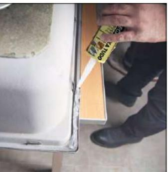
CARACTERÍSTICAS E APLICAÇÕES: Adesivo híbrido monocomponente indicado para colagem e vedação de materiais porosos e não porosos, como metais, concreto, pedras, cerâmicas, vidro, policarbonato e PVC. Devido ao alto poder de adesão inicial é indicado para a fixação de espelhos e colagem de cubas. Com propriedades de não escorrimento, cura com a umidade atmosférica, transformando-se em uma borracha flexível e resistente.
